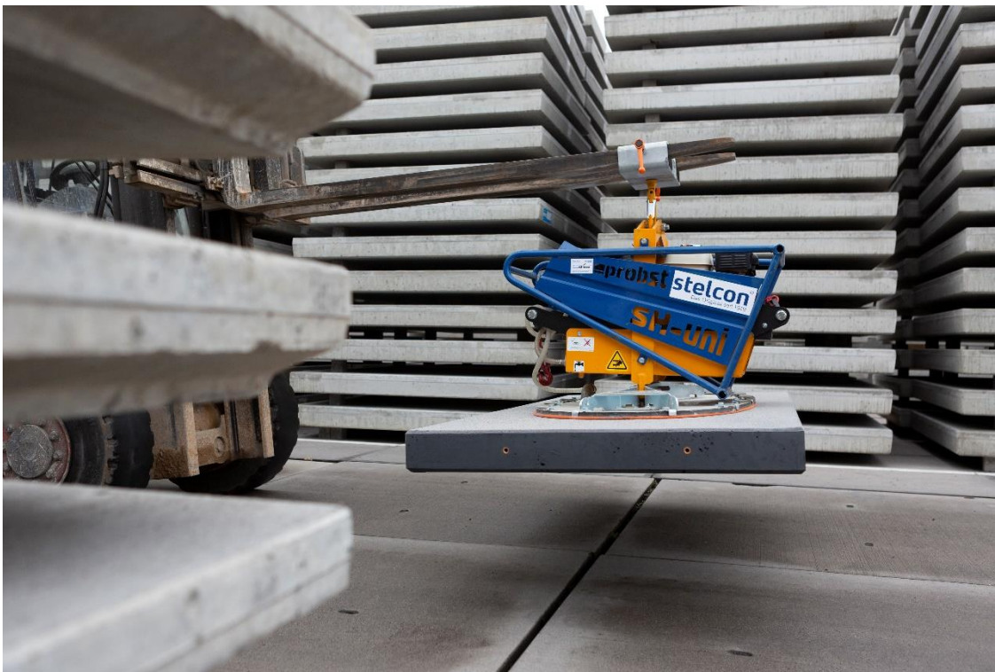
Bild 2: Verlegung mit Vakuumhebergerät
