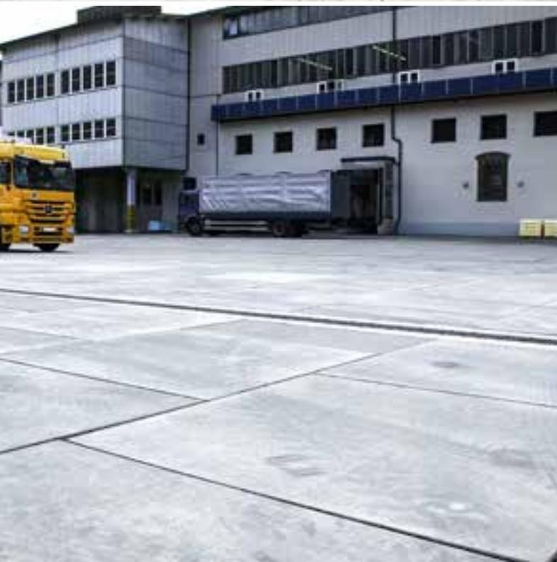
**Die einfachste Möglichkeit einer Flächenbefestigung für Fahrwege mit geringer Belastung.**
