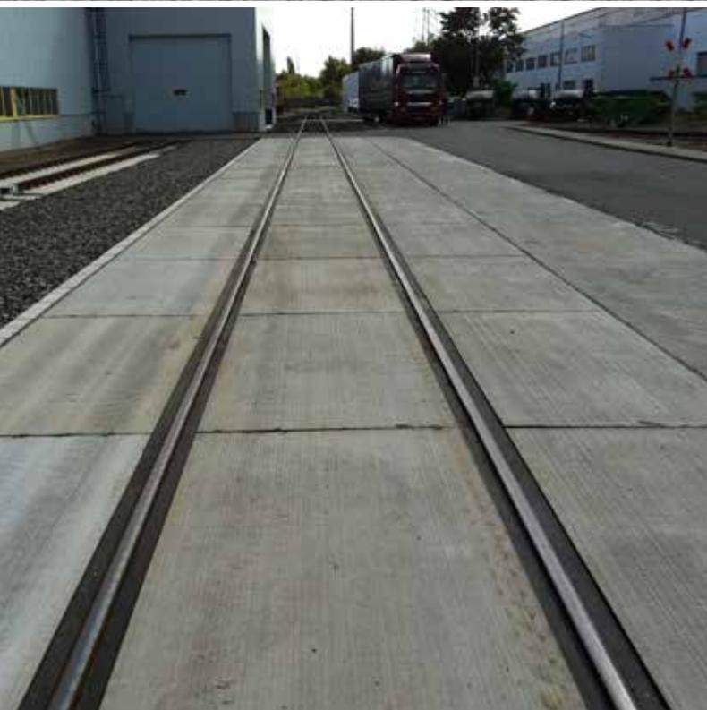
**Die CROSS EASY Innen- und Außenplatten sind je nach Beanspruchung mit oder ohne umlaufenden Winkelrahmen (Kantenschutz) erhältlich und sind sowohl für Vignol- als auch für Rillenschienen einsetzbar.**
