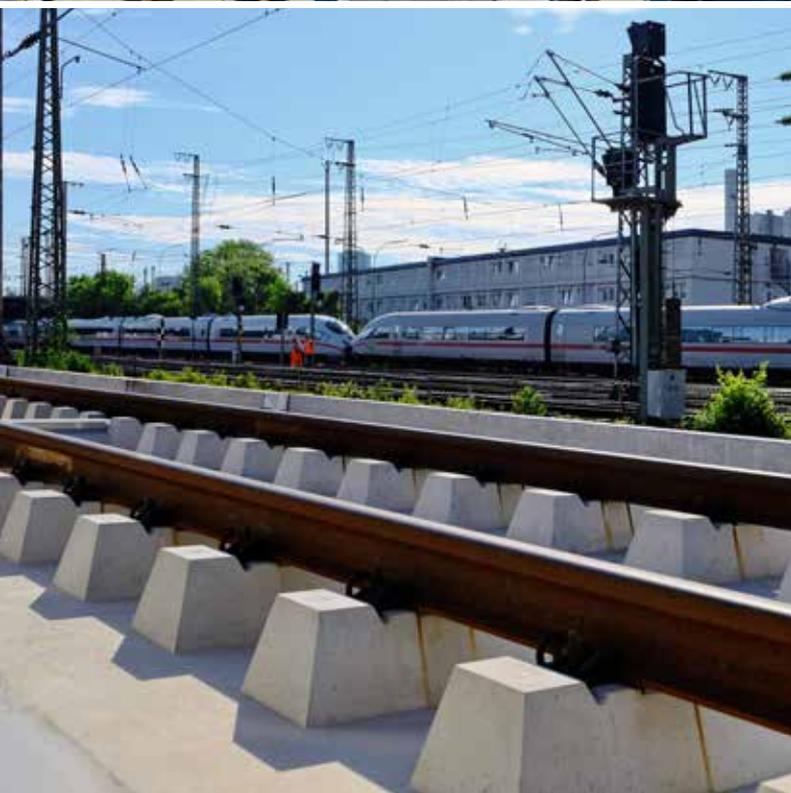
Das **stelcon® Gleistragwannensystem RAIL PROTECT EW** besteht aus Standardbetonfertigteilen mit einer Baubreite von 3,8m und ist in variablen Baulängen (2,4; 5,0; und 7,5m) verfügbar.
