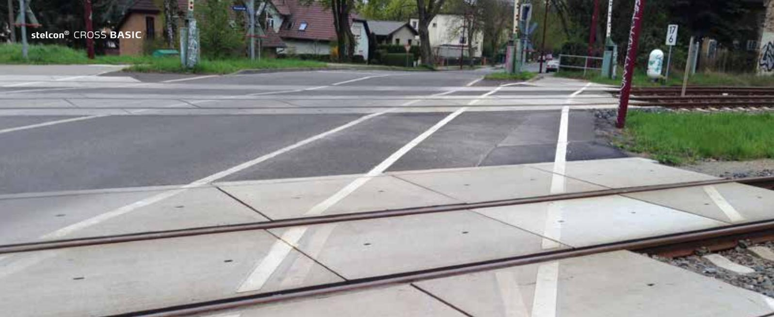
Das von Schienenform und Schwellentyp, Schwelenteilung und Oberbauform unabhängige stelcon® BÜ-System CROSS BASIC zeichnet sich durch eine griffige Oberfläche mittels Besenstrichstruktur, Schutz der Kanten, sichere Lage innerhalb des Gleisbereichs sowie geringem Zeitaufwand bei der Montage aus.
