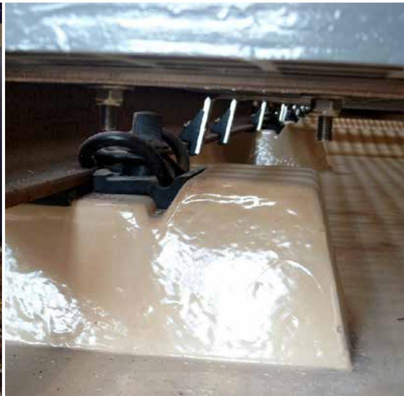
**Das aus dem stelcon® Gleistragwannensystem RAIL PROTECT EW entwickelte System RAIL PROTECT EW\_Q verfügt über eine Baulänge von 3,75 m und ist in variablen Bauteilbreiten von 4,5 – 8,5 m bauaufsichtlich zugelassen.**
