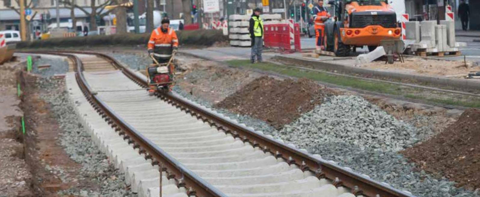
**Gleisbetonschwelle B70 – eine schnelle und zuverlässige Lösung – sowohl für Neubaustrecken als auch zur Ertüchtigung vorhandener Gleise**
