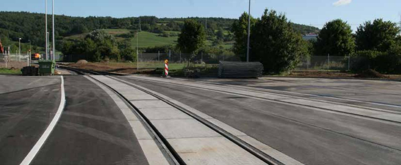
Die hochwertigen Betonfertigteile sind praktisch wartungsfrei, da durch die hohe Betonfestigkeit keine Fahrspurbildungen entstehen können und damit eine aufwendige Kontrolle des Fahrbahnbelages entfällt. Das hohe Eigengewicht der Platten garantiert auch bei extremen Belastungen ein Höchstmaß an Lagestabilität.
