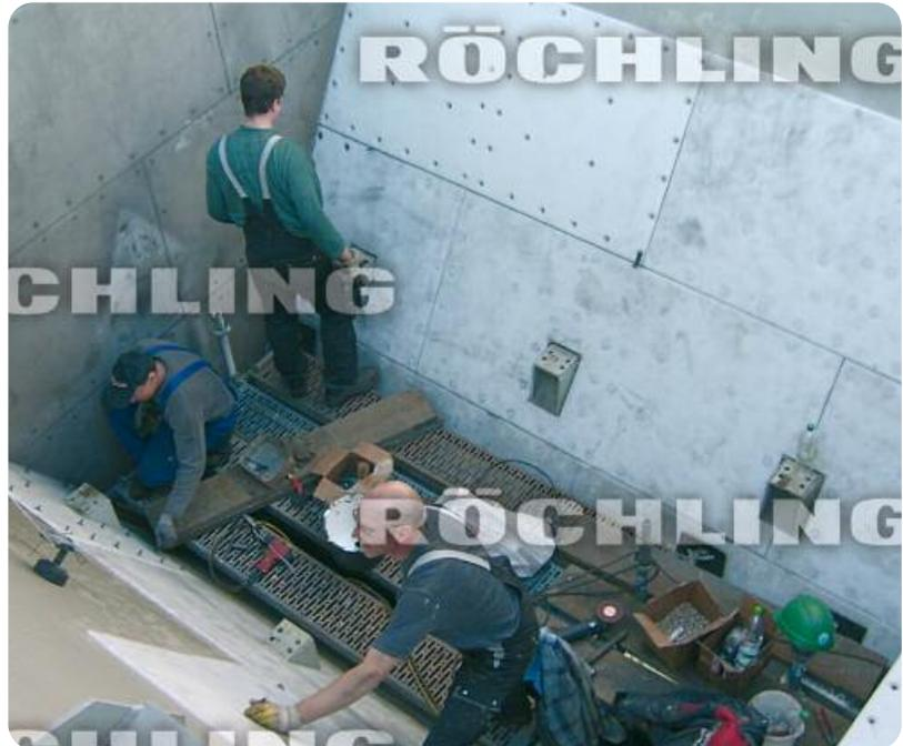
Procedimiento de soldadura de pernos: revestimiento de un depósito
