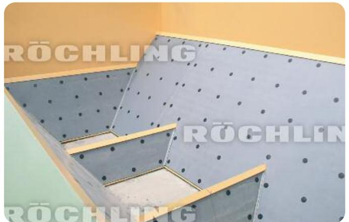
Revestimiento de depósito con arandelas soldadas: se distingue claramente la distribución de los puntos de fijación
