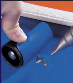
Soldadura de un parche en una lona
