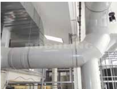
Polystone® PPs grey Lüftungsanlage
