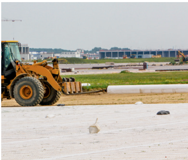
Figura 11 Instalación de Secugrid® (no se requiere pre-tensado).
