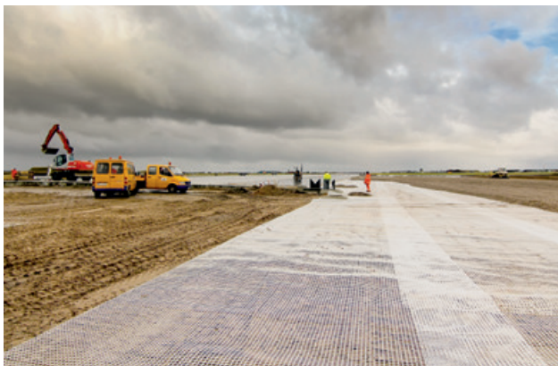
Figura 5 Instalación a gran escala de una capa de base reforzada con Secugrid®
