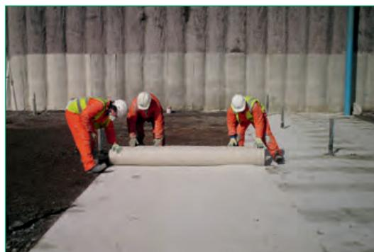
En estado seco, BENTOFIX® BFG 5000 tiene un espesor de aproximadamente 7 mm. Una vez hidratado, el espesor del producto aumenta, dependiendo de la tensión de confinamiento, aproximadamente otros 4 mm.
