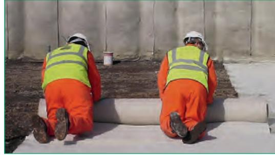
Desenrollado de la membrana BENTOFIX® sobre una base
