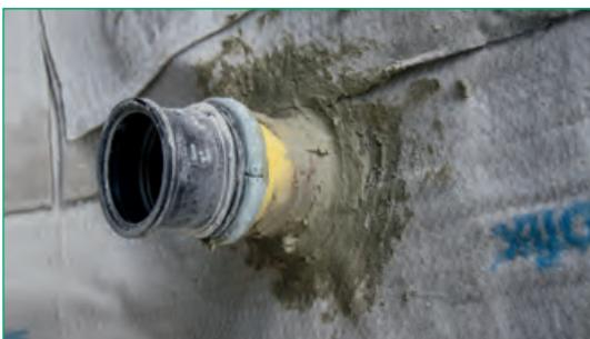
Penetración de tubería sellada con BENTOFIX®
