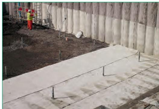
Aunque recomendamos instalar BENTOFIX® BFG 5000 en estado seco, se ha utilizado en muchos proyectos de construcción donde la bentonita se hidrataba antes de entrar en contacto con la estructura o el suelo. La construcción perforada del producto evita que la bentonita se entienda mediante el confinamiento del material expandido dentro del revestimiento compuesto. Sin embargo, una vez que la membrana esté hidratada se deben evitar puntos de presión mayores.
