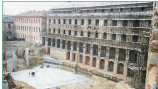
Impermeabilización de un sitio con BENTOFIX®
