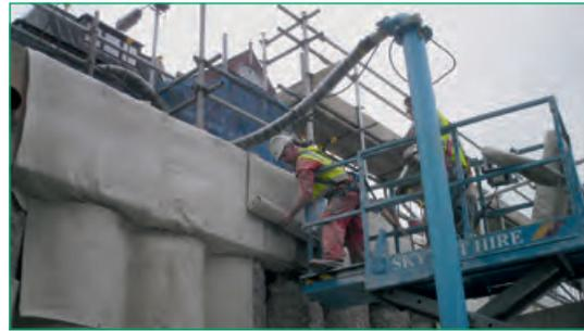
Fijación vertical de BENTOFIX® contra una fachada de concreto
