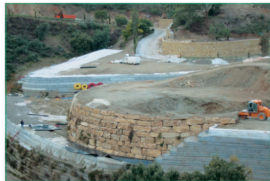
Figura 55 Construcción de un muro de contención usando Secugrid® (Marbella Hill, España).
