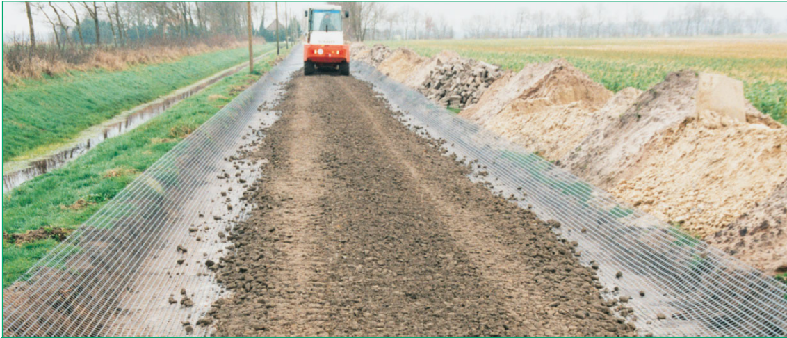
Los geosintéticos NAUE se pueden utilizar en diversas soluciones de sistemas, tales como en la construcción de carreteras para aumentar la capacidad de soporte y para reducir la formación de surcos por rodadura...
