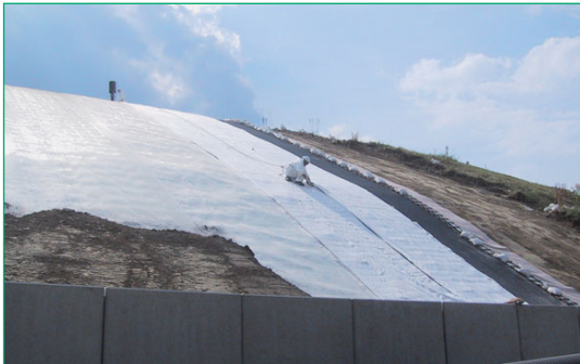
... En pendientes pronunciadas para mejorar la estabilidad de taludes y control de erosión,...
