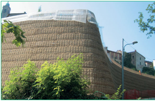
Figura 54 Muro de tierra reforzado con Secugrid® (Vignale, Italia)
