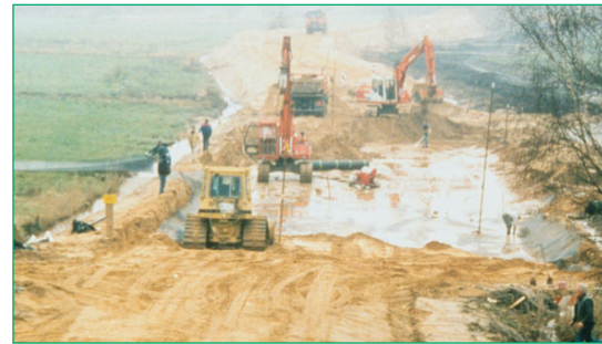
Figura 16 Uso de Secugrid® para el reforzamiento de un respro (Loxstedt, Alemania).
