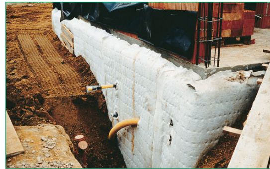
Figura 65 Relleno contra sistema Secudrain®
