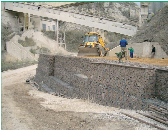
Figura 59 Muro de gavión reforzado con Secugrid® (Tman, República Checa).
