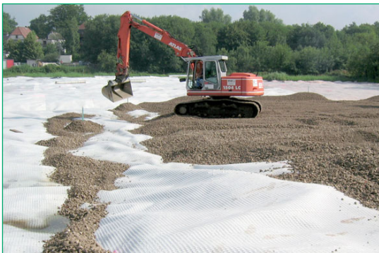
Figura 74 Colocación de suelo sobre Combigrid® y un suelo blando extremadamente débil (Alemania).
