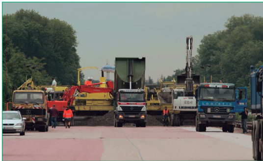
Figura 20 Geotextil Secutex® como separador en una construcción de carreteras (Weißenfels, Alemania).
