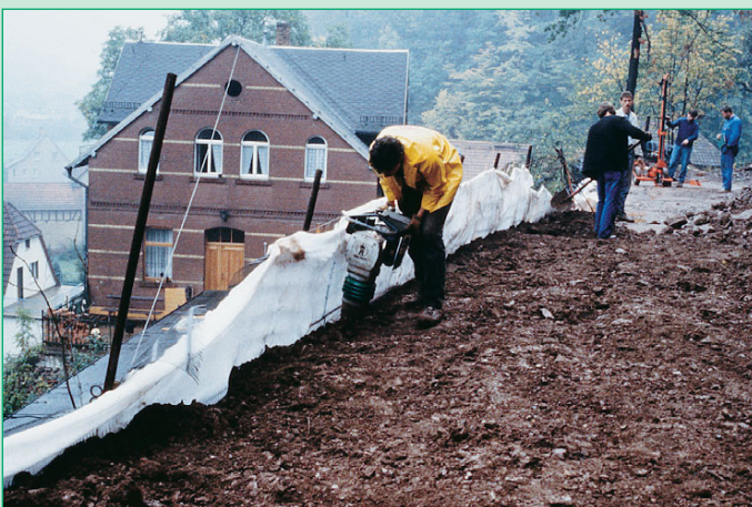
Figura 6: Secutex® como un filtro geotextil en un muro de contención para evitar el arrastre de finos en la cara frontal.
