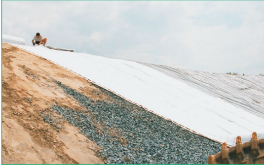
Figura 49 Estabilización de talud y captación de aguas de infiltración con Secudrain®.
