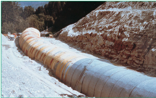
Figura 68 Secudrain® como colector de agua de precipitación y de aguas subterráneas en un túnel (Pustertal, Italia).
