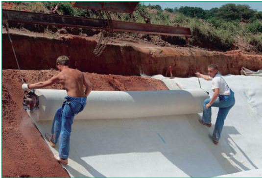
Figura 33 Instalación de Bentofix® con una barra de tensión en una cuneta de carretera (Muenster, Alemania).
