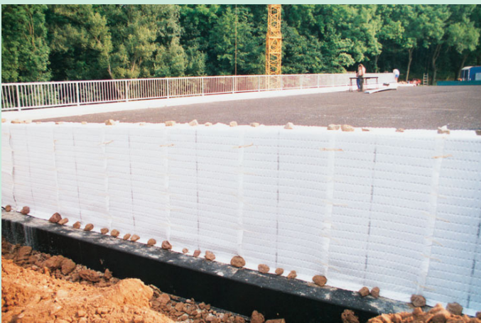
Figura 11: Secudrain® en un estribo de puente garantizando drenaje a largo plazo.
