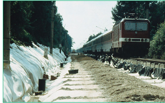
Figura 40 Uso de Bentofix® GCL bajo vías férreas para la protección de aguas subterráneas (Dresde a Leipzig, Alemania).
