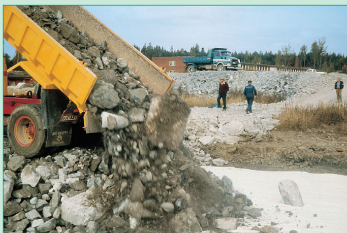
Figura 3: Los geotextiles no tejidos Secutex® pueden resistir altas fuerzas dinámicas de instalación.
