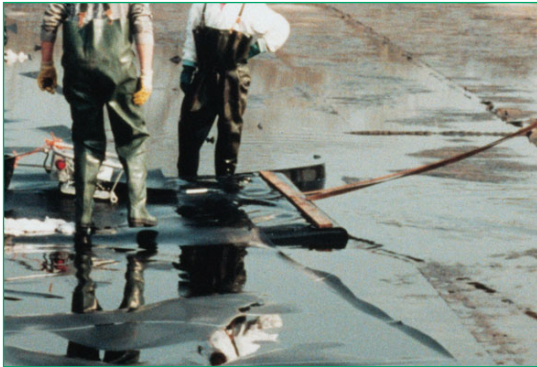
Figura 78 Soldadura de la barrera de gas Carbofol® en un estanque de lodos (Rositz, Alemania).
