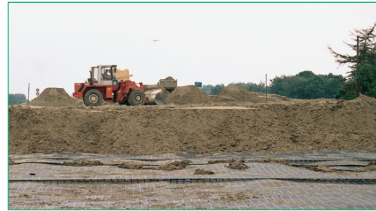
Figura 21 Prevención de falla de subsuelo con Secugrid® 400/60 R 6 (A 31, Emden, Alemania)
