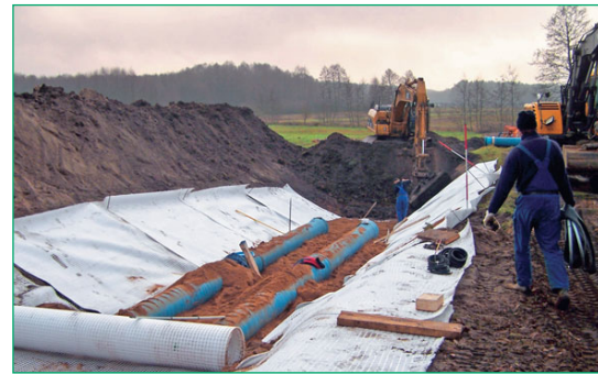
Figura 83 Aumentando la capacidad portante del suelo con Combigrd® en una zanja de tuberías (Briesen, Alemania).
