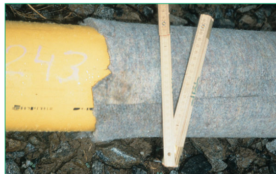
Figure 88 Protección con geotextiles no tejidos Secutex® para tuberías (Arnstorf, Alemania)
