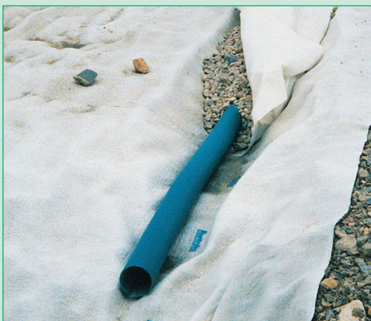
Figura 8: La tubería lateral de captación de aguas pluviales y de drenaje se envuelve con un geotextil Secutex® para prevenir que los finos obstruyan el desagüe.
