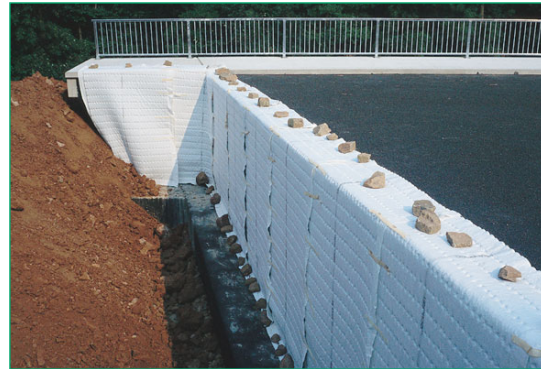
Figura 70 Secudrain® instalado en una estructura de puente (Grossen-Marpe, Alemania).
