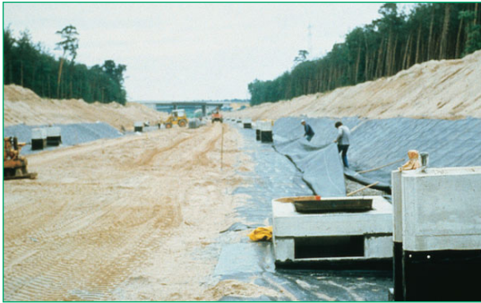
Figura 39 Geomembranas Carbofol® en una zona sensible de aguas subterráneas (Reino Unido).
