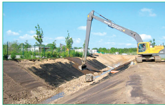
Figura 46 Control de la erosión en una pendiente. La estructura de poro abierto de Secumat® permite el fácil llenado de la capa superior del suelo.
