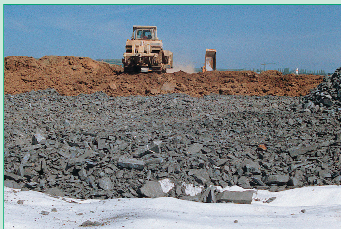
Figura 2: La elevada capacidad de elongación de Secutex® garantiza una excelente resistencia a los daños.
