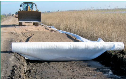
Figura 25 Instalación de Combigrig® para aumentar la capacidad portante del suelo (Bremerhaven, Alemania).
