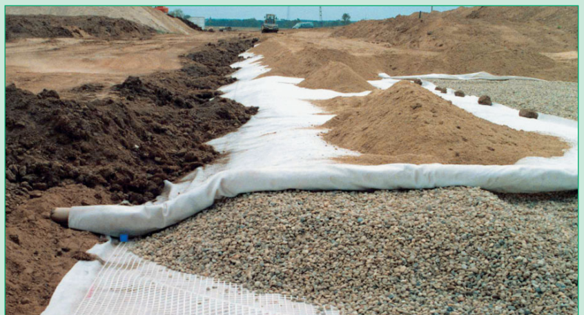
Figura 9: Secutex® separa la capa de drenaje de grava del subsuelo limoso.
