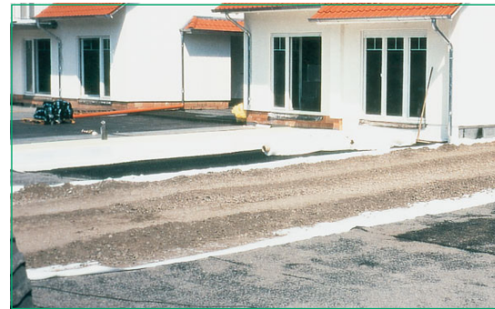
Figura 26 Separación y filtración con Secutex® en un camino de entrada (Gehlenbeck, Alemania).
