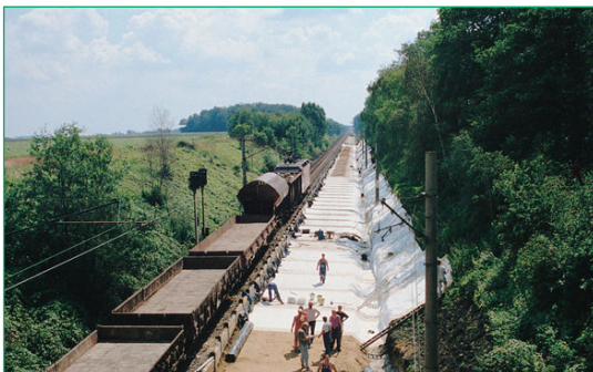
... En la construcción de rutas de transporte para sellar el subrasante en las aéreas sensibles de protección de aguas subterráneas...
