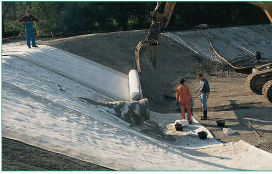
Figura 38 Instalación de Bentofix® GCL en un estanque de captación de aguas pluviales.
