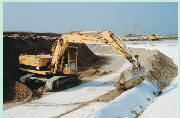
Figura 7: El filtro de geotextil Secutex® garantiza que los finos no serán arrastrados fuera del represo de filtración.
