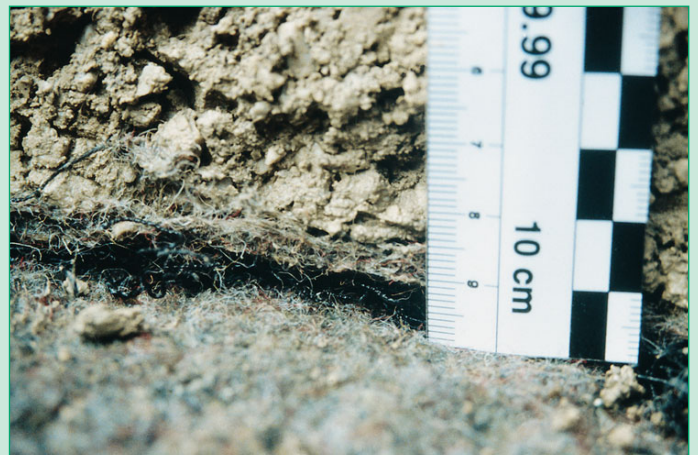
Figura 12: Espesor medido in-situ de Secudrain® después de más de 12 años con una tensión de confinamiento del suelo de cubierta de 1.20 m.
