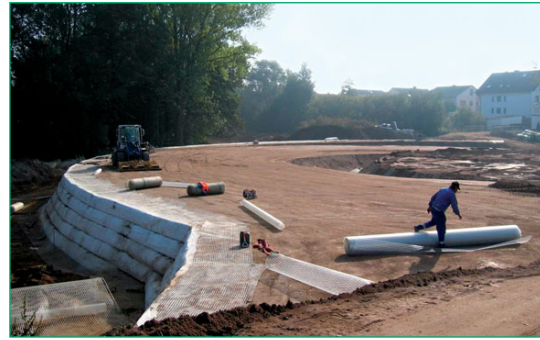
Figura 51 Reforzamiento de terraplén con Secugrid® en un proyecto de ampliación de una carretera (Tabing-Doku, Indonesia).
