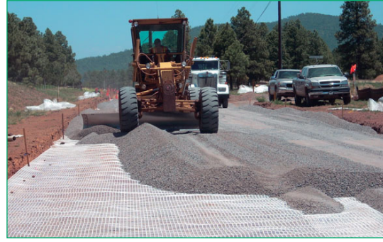
Figura 30 Cobertura del suelo con refuerzo de Secugrid® en una capa de base (Arizona, EE.UU.).
