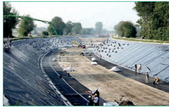
Figura 21 Instalación de Carbofol® para rehabilitación de un canal de una planta hidroeléctrica (Mittlere-Isar-Kanal, Erding, Alemania).
