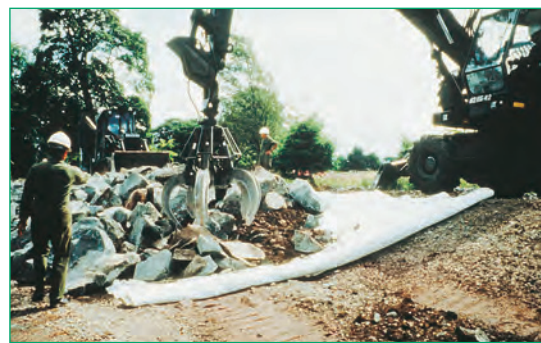
Figura 19 Instalación de pedraplén sobre filtros de geotextiles Terrafix® no tejidos.
