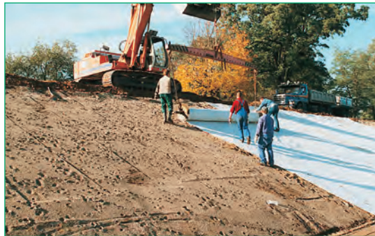
Figura 40 Instalación de Bentofix® con una excavadora equipada de una sola barra separadora (Lebus, Alemania).
