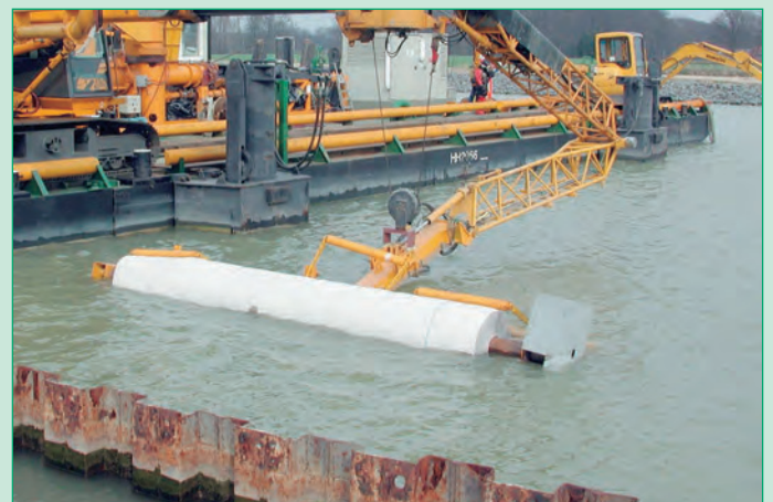
Figure 8: Instalación bajo abajo de Bentofix® BZ 13-B con plantilla de arena.
