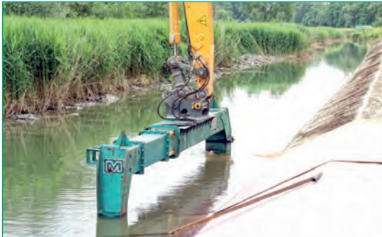
Figura 18 Instalación submarina de Plantillas de arena Terrafix® como protección con socavación (Feldheim, Alemania).
