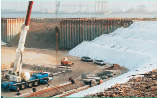
Figura 27 Plantilla de arena Terrafix® para el control de la erosión (Tunel Warnow, Rostock, Alemania).
