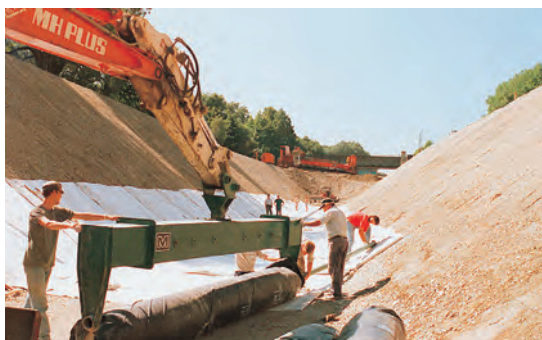
Figure 28 Instalación de Bentofix® como material de sellado secundario (Isarkanal, Munich, Alemania)
