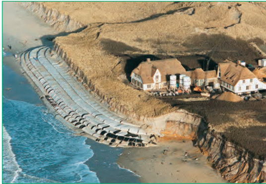
Figura 11 El método de construcción de colchón Terrafix® estabiliza el litoral en frente de Haus Kliffende (Sylt, Alemania)
