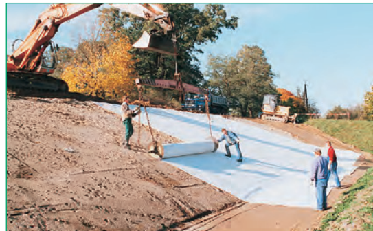
Los revestimientos geosintéticos Bentofix® de arcilla se usan solos como membrana de sellado en diques y presas.
