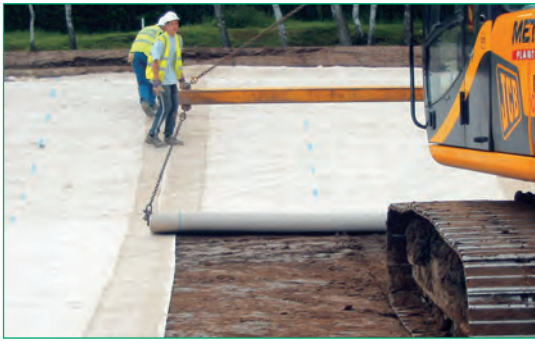
Figura 36 Impregnación de bentonita manufacturada en fábrica en los traslapes y las marcas de tinta del traslape de Bentofix®.
