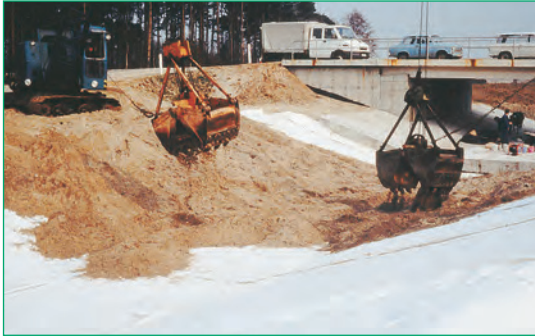
Figura 20 Cubierta de revestimiento de arcilla geosintética Bentofix® (Cottbus, Alemania).
