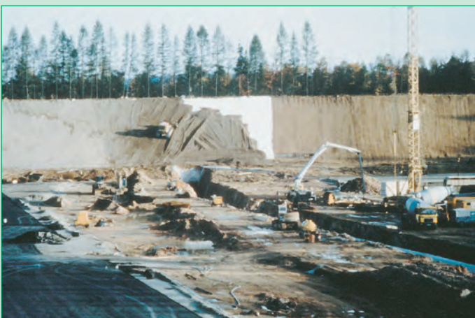
Figure 7: Sellado de una cisterna de agua con Bentofix® GCL perforado con aguja.
