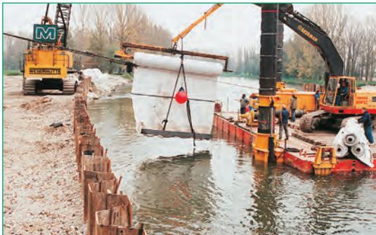
Geotextiles Terrafix® de filtración y estables no tejidos, plantillas de arena de filtración estables son adecuadas en vías navegables, ríos y canales para la protección de lechos de ríos y sus terraplenes.
