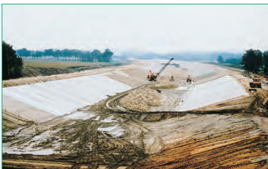
Geotextiles Terrafix® no tejidos con una sola capa y con múltiples capas y lavado debajo del revestimiento.
