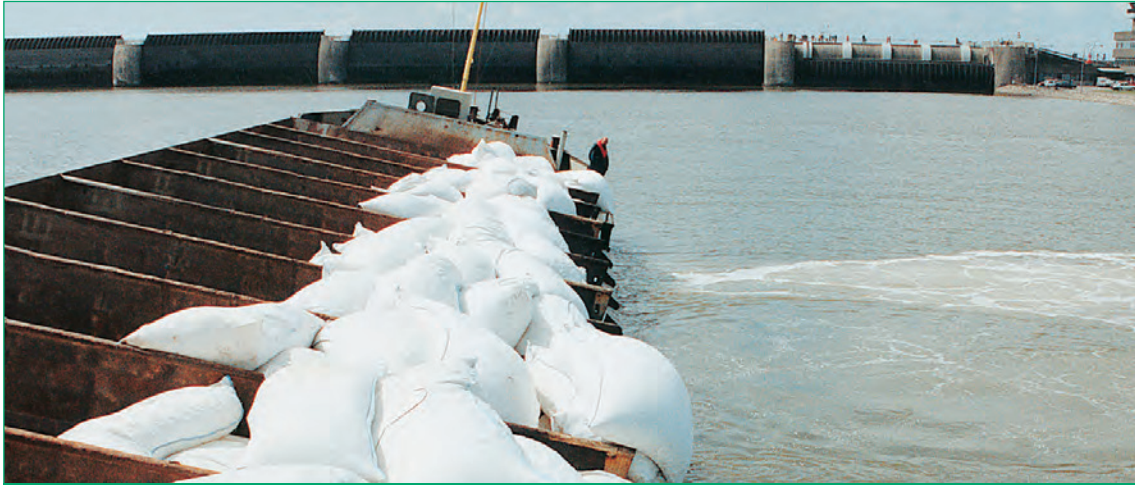
Los contenedores de geotextiles no tejidos de roca suave rellenos de arena se usan para proteger contra la socavación o para la construcción de rompeolas.
