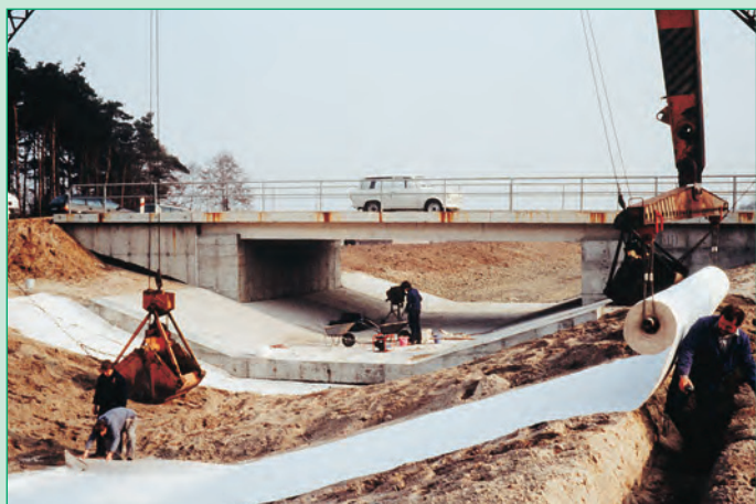
Figure 5: Instalación de Bentofix® GCL en un canal.
