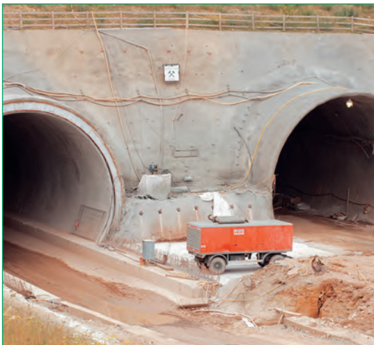
Fig. 1: Área del portal del túnel
