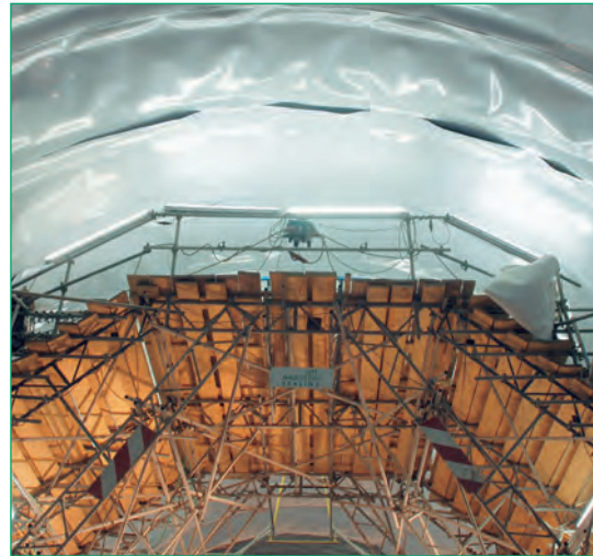
Fig. 31: Geomembranas de túnel Carbofol® sobre un andamio de arco.
