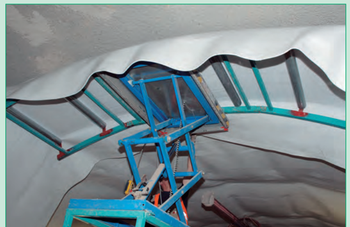
Fig. 26: Asegurando el geotextil de protección Secutex® (área de arco)
