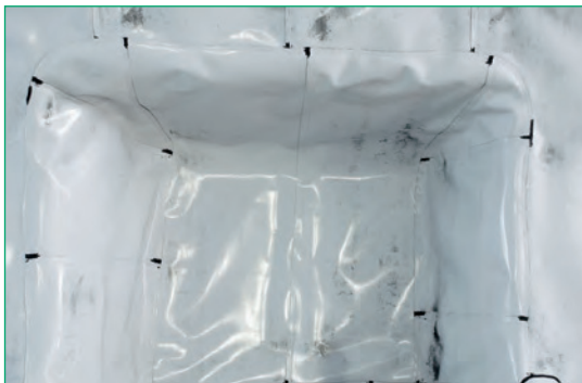
Fig. 32: Soldando una junta a la geomembrana de túnel Carbofol®
