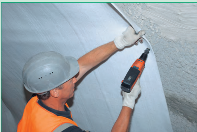
Fig. 25: Unión del geotextil de protección Secutex® en el muro lateral de la capa transportadora de sellado.
