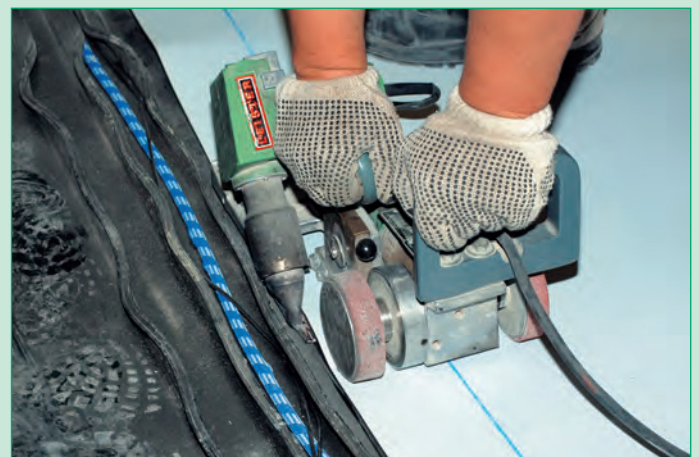
Fig. 34: Soldando una junta a la geomembrana de túnel Carbofol®
