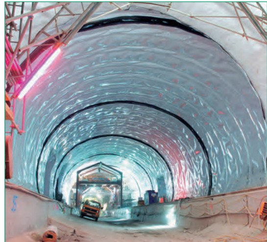
Fig. 2: Sellado de arco, usando geomembrana de túnel Carbofol®
