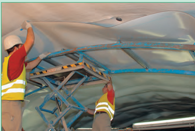
Fig. 29: Instalación de la geomembrana de túnel Carbofol® en el arco.
