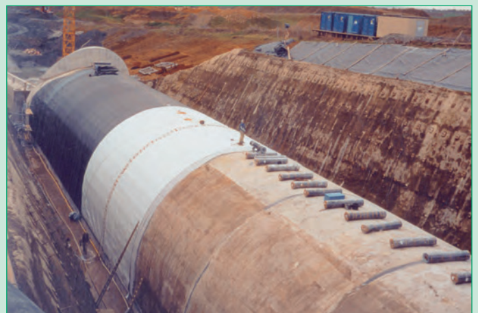
Fig. 23: Área de portal con geomembrana de túnel Carbofol®
