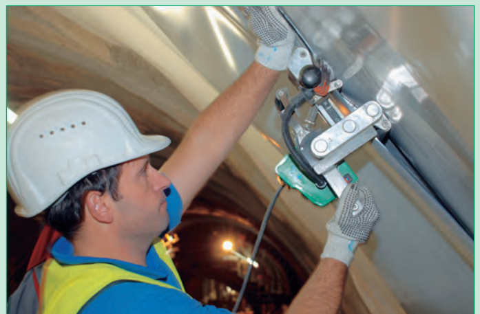
Fig. 30: Soldado de la geomembrana de túnel Carbofol® usando una máquina de soldadura de cuña en caliente.
