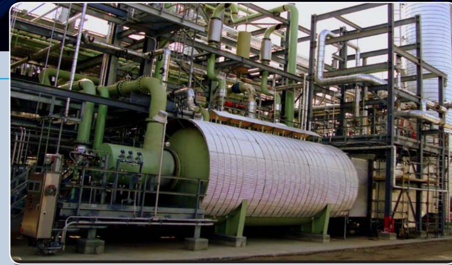
Oxidador térmico de gas de cola para URA con caldera de calor residual de estilo tubo de agua.
