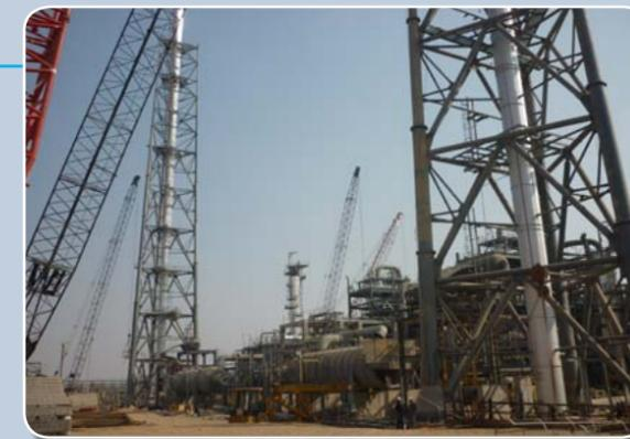
Montaje de la chimenea de venteo de un oxidador térmico de gas de cola de azufre. Los ingenieros de campo de Zeeco están completamente preparados para asistir en todos los esfuerzos de montaje y puesta en servicio de los equipos.
