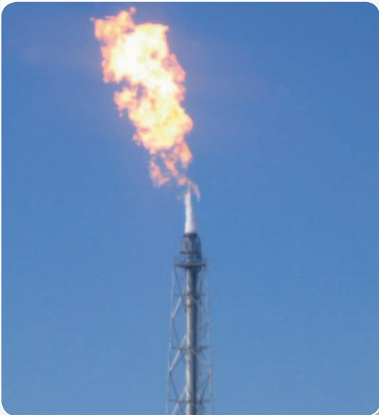
Antorcha HCL de alta eficiencia asistida por vapor / bajo ruido
