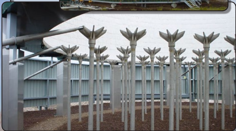
Flare de Terra Enclausurado com Cabeçotes de Queimador Fundido de Câmara Interior
