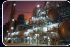
Wärmeoxidierer zur SRU-Abgasreinigung mit Flammrohr-Abhitzekeessel und Dampftrommel. Eine von neun ähnlichen Verbrennungsanlagen, die von Zeeco geliefert wurden.
