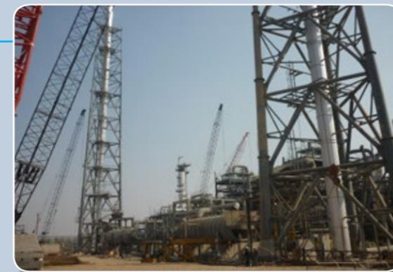
Errichtung eines Abluftkamins für einen Schwefelabgas-Wärmeoxidierer. Zeecos Support-Ingenieure vor Ort sind voll ausgestattet, um Sie bei allen Fragen zur Gerätemontage und Inbetriebnahme zu unterstützen.
