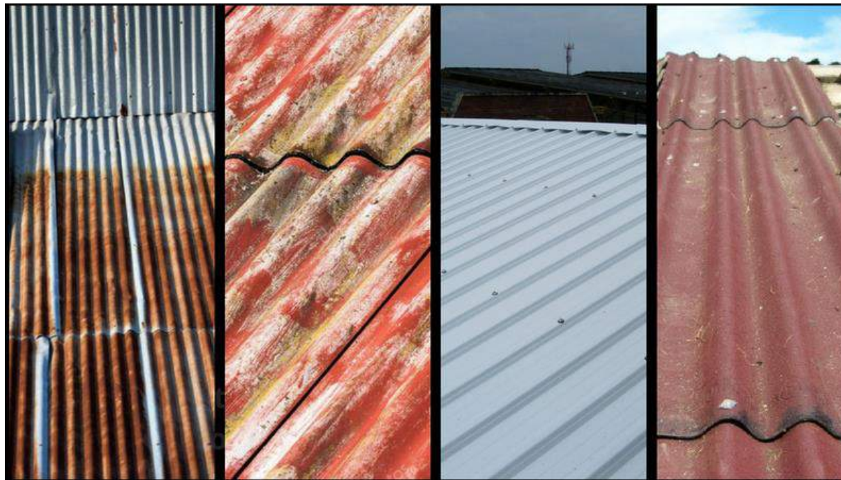
Figura 48. En esta imagen se aprecia la garantía anticorrosión que tiene la lámina PVC tricapa en comparación de otros tipos de láminas. Cabe mencionar que con el paso del tiempo la lámina PVC tricapa puede tornarse un poco amarillenta.
