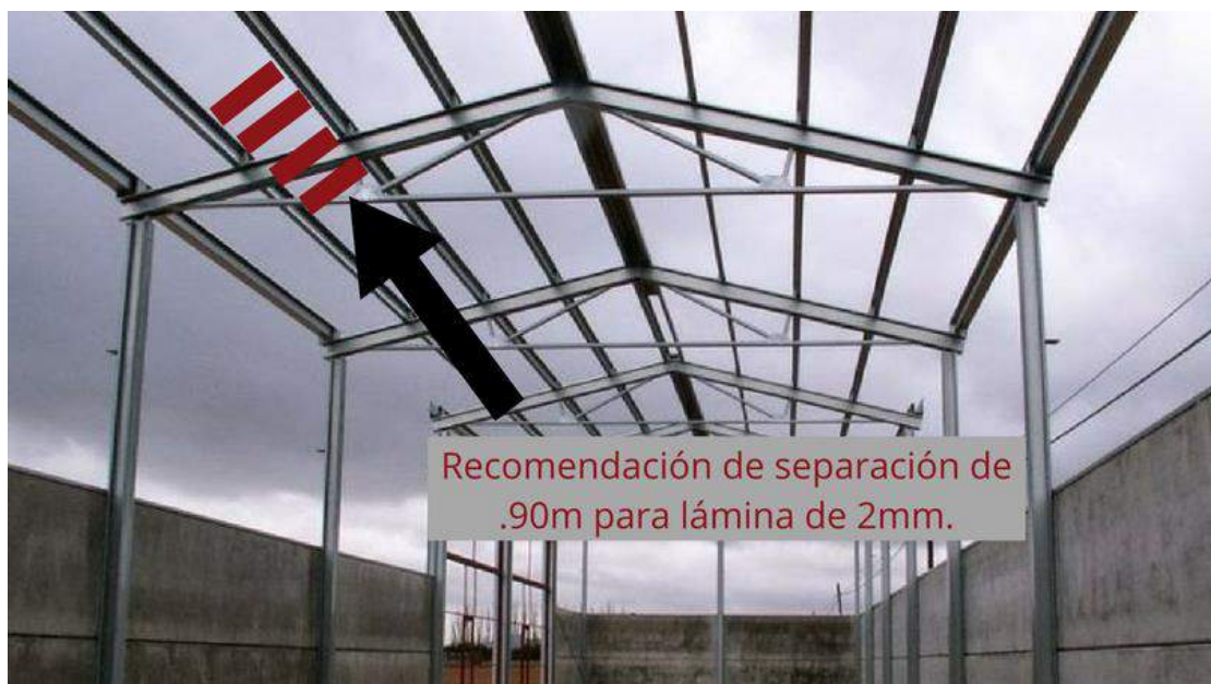
Figura 14. Instalación de la lámina de PVC tricapa. En esta imagen se aprecia la distancia entre los largueros o soportes como una recomendación para instalar láminas de 2mm de espesor.
