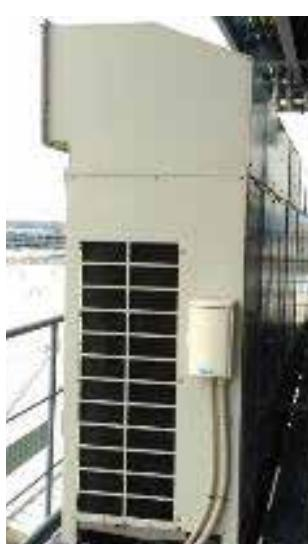
SEACSとは、送風は止めず、冷温風を作る圧縮機を短時間止めることを繰り返して体感温度を変えることなく、省エネを図る室外機あと付け制御装置。
