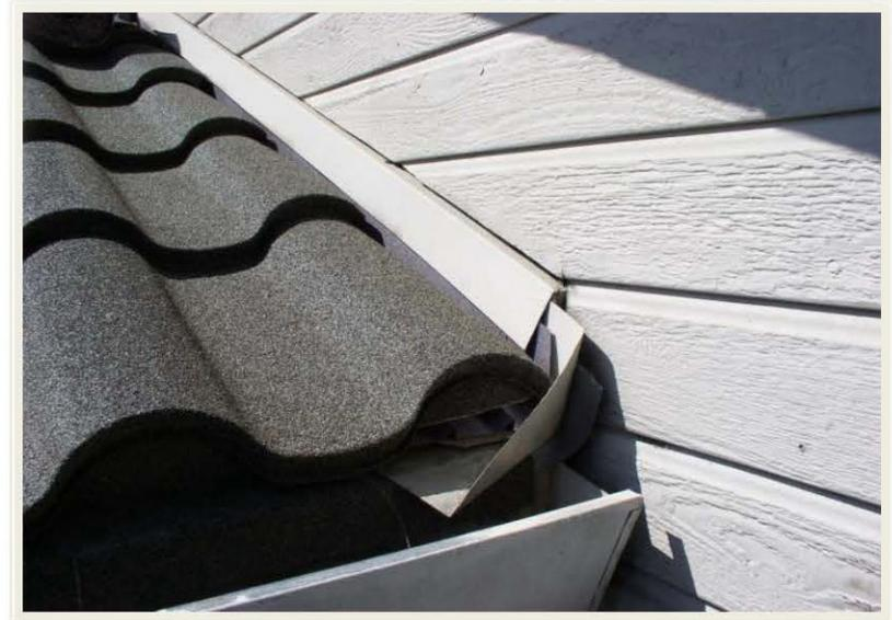
Si se ha empleado un botaguas sobre la pared, pliegue la pieza Villa Channel (canal limatesa) detrás del botaguas existente – corte las tejas y encaje hacia la Villa Channel.
