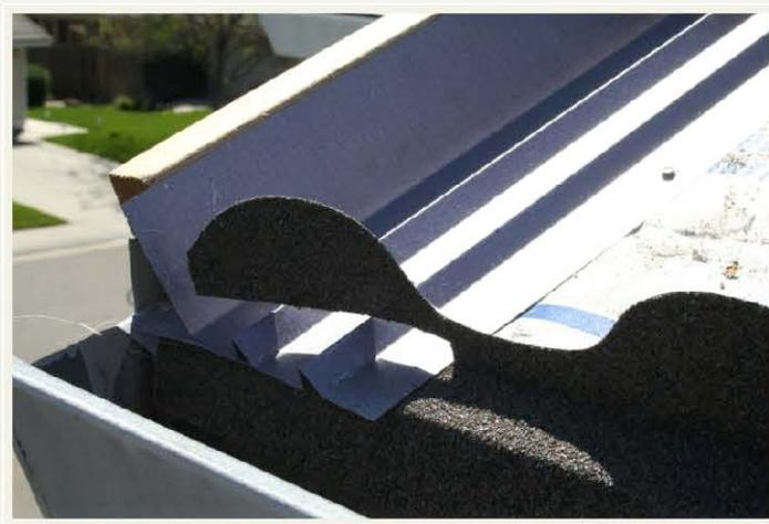
Los extremos del Bird Stop Eave deben cortarse a medida para quedar aseguradas donde se encuentran con el Villa Channel – Fijar cada 10" (25 cm).
