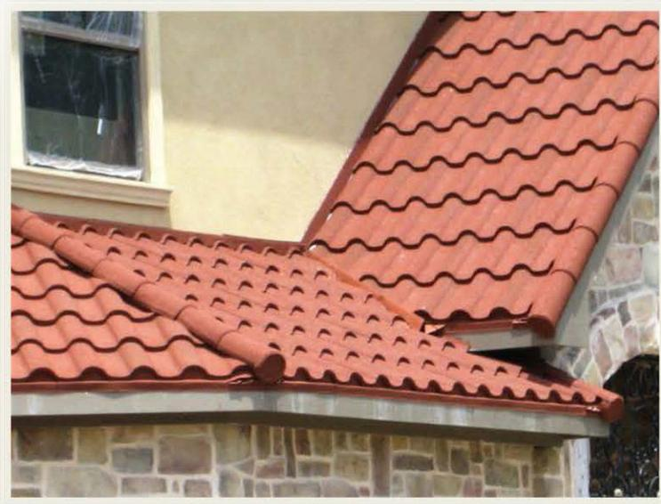
Proceda instalar las tejas por hileras hasta llegar a la pared y corte la parte posterior del último panel de la última hilera para que quede ajustado contra la pared– coloque las piezas Bird Stop – Ridge (remate cumbre).
