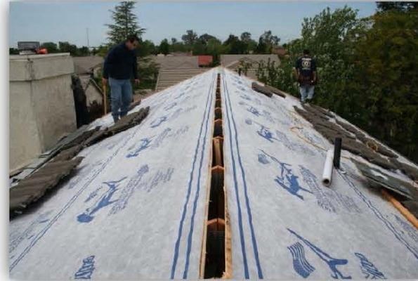
El revestimiento empleado debe cumplir con las especificaciones: ASTM D 226, de Tipo I o Tipo II, ASTM D 4869, Tipo I o II o ASTM D 1970 – o mayor si así lo requieren los códigos de construcción locales vigentes.
