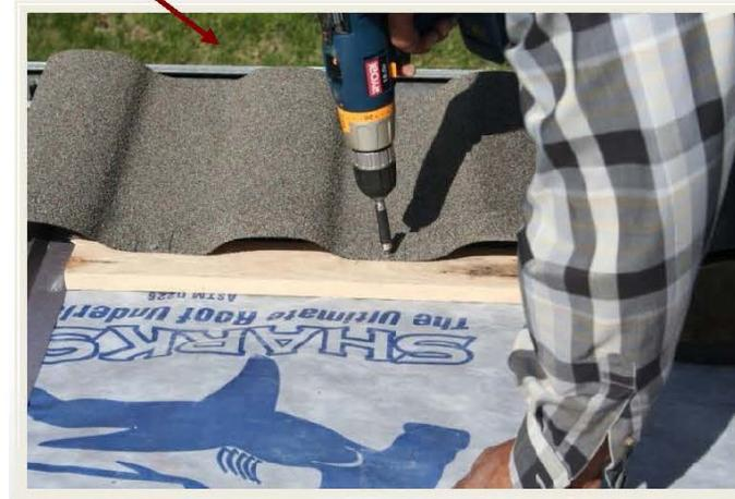
Fije al deck empleando tornillos de cabeza hexagonal N°9 (1/4" de diámetro) x 1-1/2" de largo ((0,63 cm de diámetro) x 3,8 cm de largo) que encajen al ras y penetren el deck.
