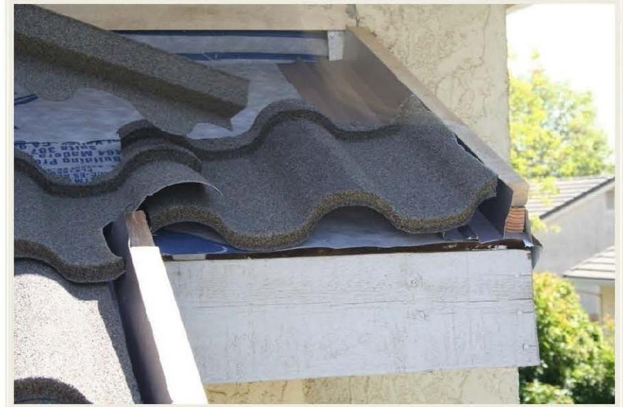
Una hilera corta se inserta cortando la parte de atrás las tejas de la hilera inferior y colocando las tejas enteras encima de las mismas. Las tejas enteras se sujetan por la nariz sobre la parte más alta las tejas de abajo.
