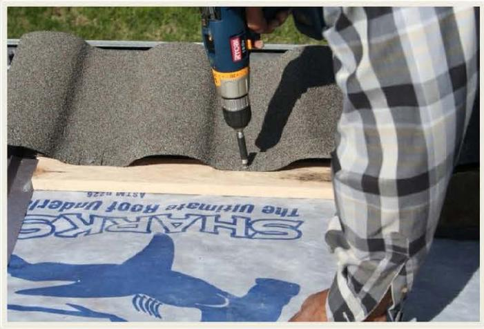
En la primera hilera de tejas, solamente fije la parte trasera. La nariz de la primera hilera podrá ser fijada después de que se hayan instalado un mínimo de dos hileras y se hayan colocado las piezas Bird Stop-Eave (remate para aleros).
