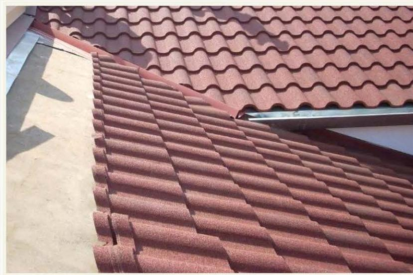
Chequee periódicamente la alineación de las tejas, marcando con tiza líneas de 14-1/2" (36,83 cm) de intervalos.
