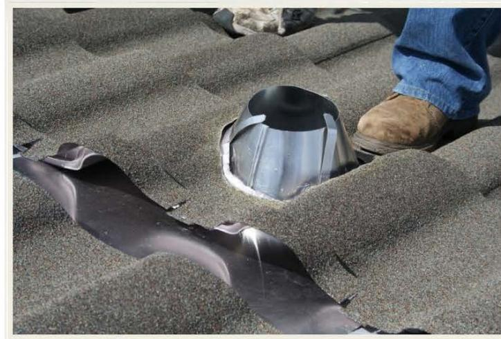
Corte la pieza Villa Underpan (bandeja de desagüe) para que ajuste firmemente. Ajuste de manera que encaje alrededor del caño de salida. Aplique silicón para intemperie por arriba y por los dos lados y termine con el kit de retoque.
