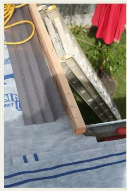
Coloque la pieza Villa Channel a nivel del borde lateral del techo, de techo-a-pared y a lo largo de los dos lados del clavador 2 x 2 (5 cm x 5 cm), a nivel de la limatesa.
