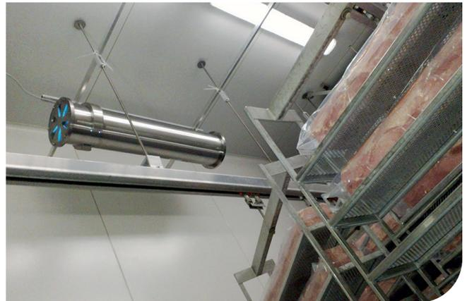
Forciertes Lufttunnelsystem im Kühlagererraum zur Reduktion von Mikroorganismen auf dem Schinken vor dem Schneiden.
