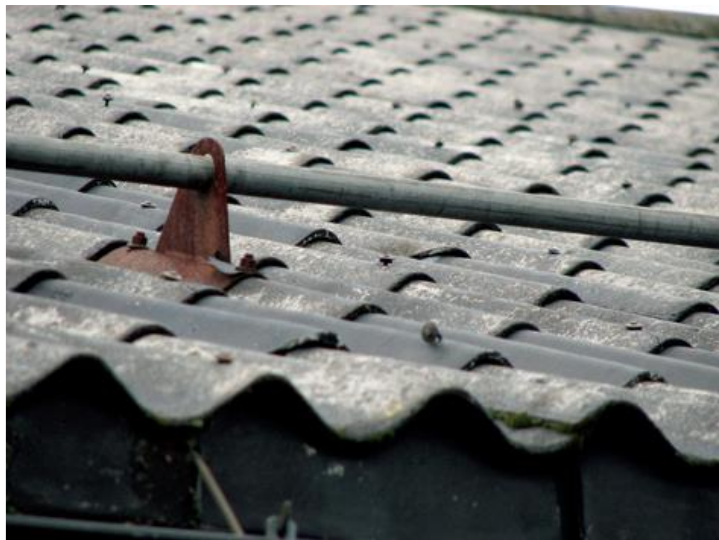
TAK : Bølgeeternitt ; Foto : Sintef byggforsk
