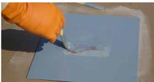
Базовый слой MarineMEND, нанесенный кистью.
