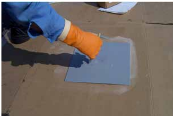
Верхний слой MarineMEND, нанесённый кистью.
