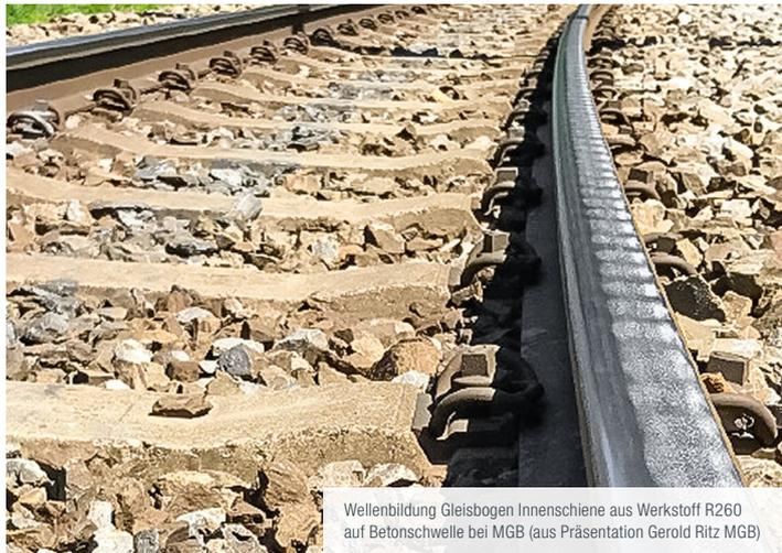
Wellenbildung Gleisbogen Innenschiene aus Werkstoff R260 auf Betonschwelle bei MGB (aus Präsentation Gerold Ritz MGB)
