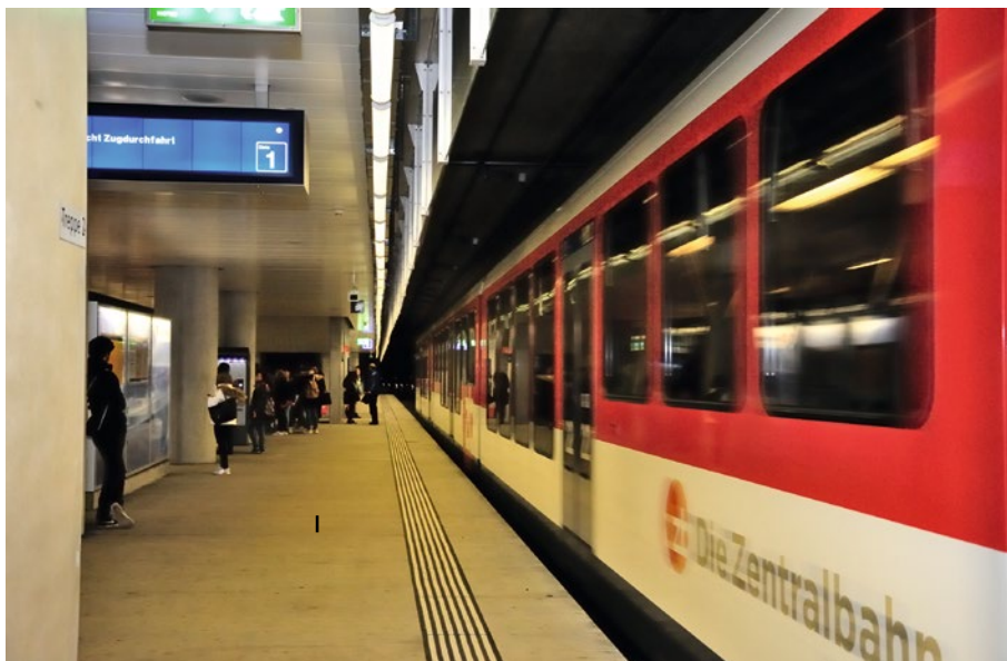
Abb. 6: Untergrundbahn-Feeling bei der zb Zentralbahn an der Haltestelle Messe Allmend in Luzern.
