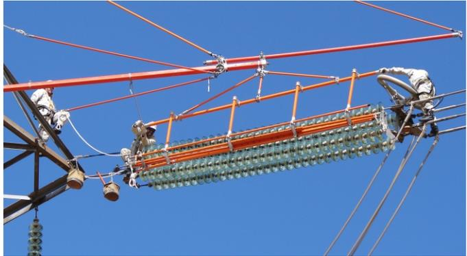
La pértiga pluma con mástil está diseñada a los servicios pesados en estructura de alta tensión, especialmente para quitar cadenas aislantes, con la ayuda de la cuna.
