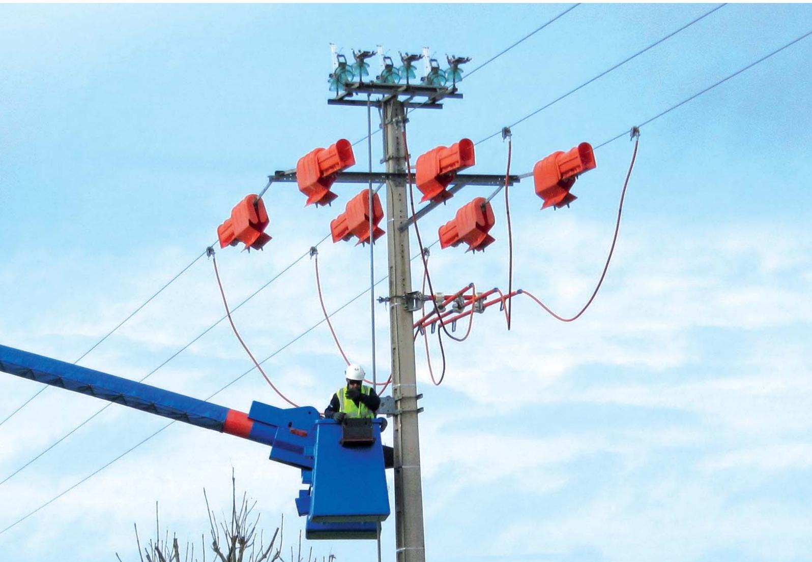
La práctica del trabajo con tensión necesita un conjunto de herramientas e instrumentos que respondan a las características de resistencia mecánica y de aislamiento definidas por la norma IEC.
