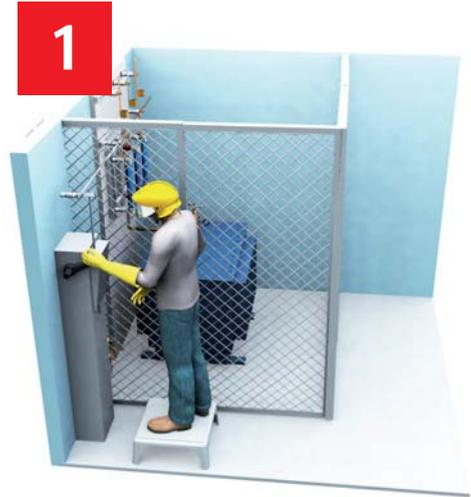
SECCIONAR LAS LÍNEAS DE LAS FUENTES ENERGIZADAS
