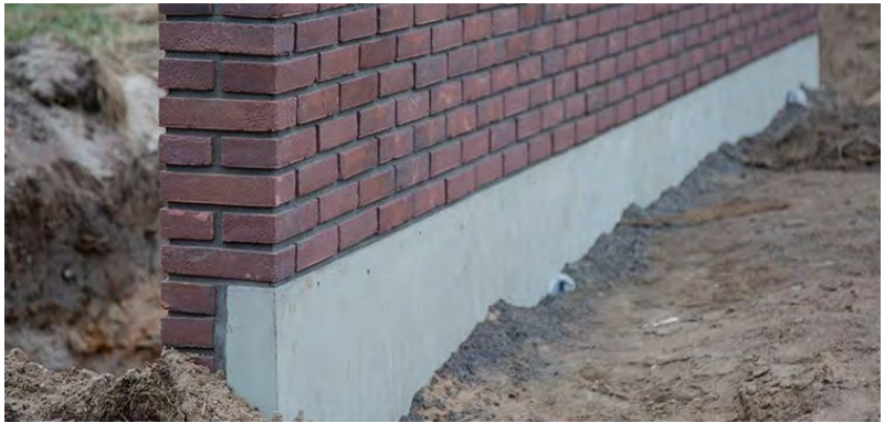
Combinatie van L-element en gemetselde muur
