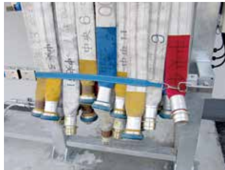
▲上部に持ち上げた際に下にある連結部は、風により煽られないようにベルトで固定します。
