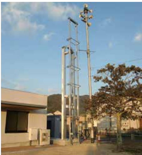
▲水に濡れたホースを乾かすためにホースハンガーに掛け、電動もしくは手動にて上部に持ち上げます。
