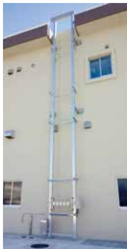
▲水に濡れたホースを乾かすためにホースハンガーに掛け、電動もしくは手動にて上部に持ち上げます。
