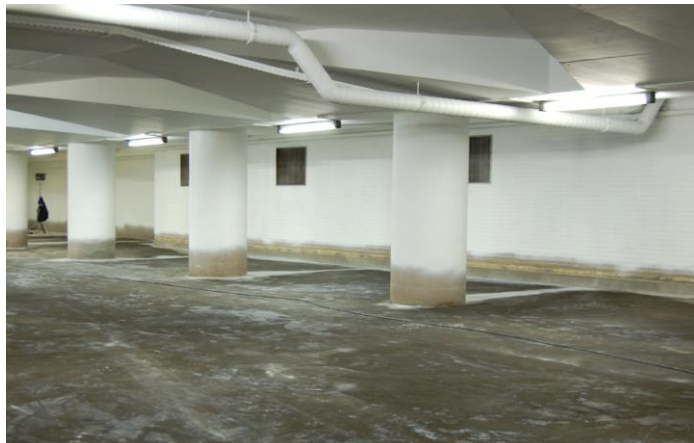
Onze referentie in Tilburg (Nederland): Parkeergarage Koningsplein
