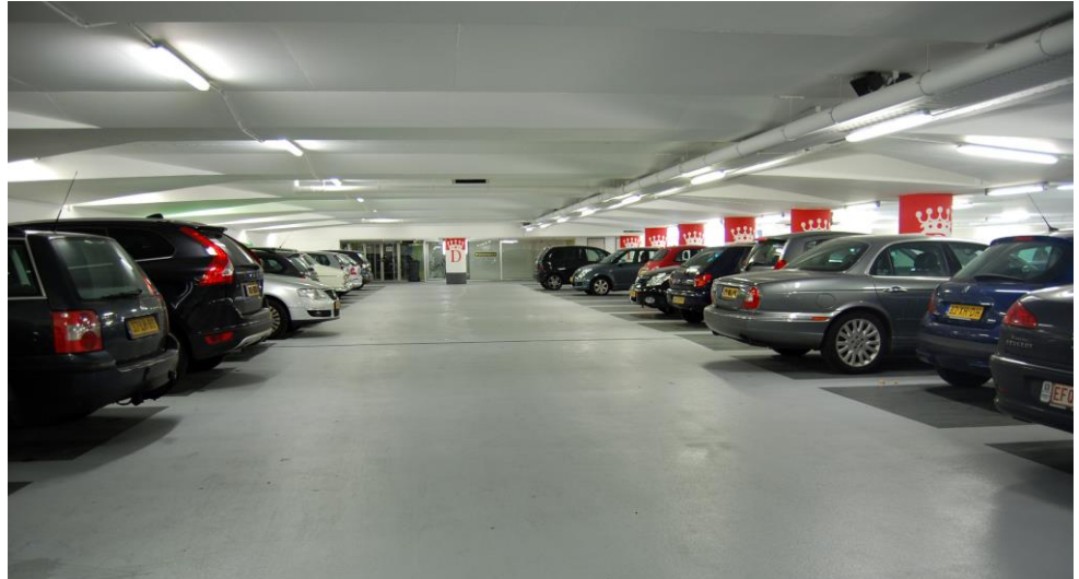
Onze referentie in Tilburg (Nederland): Parkeergarage Koningsplein
