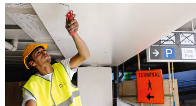
Ręczne nanoszenie MasterProtect 330 EL (parking na lotnisku w Brukseli, Belgia)
