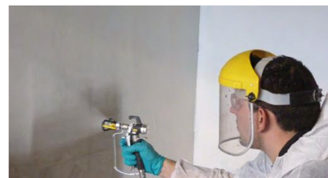
Maszynowe nanoszenie MasterProtect 330 EL w celu pokrywania pęknięć i ochrony przed karbonatyzacją betonowej ściany garażu podziemnego.
